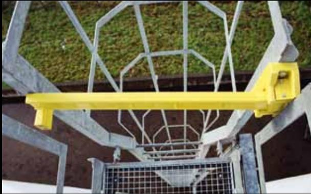
► Axes Gate Simple / échelle à crinoline sur silo
