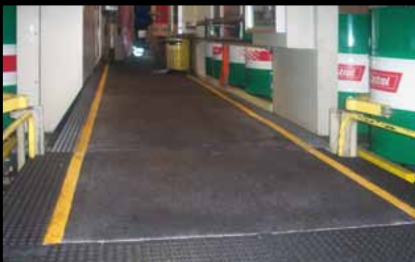
► Xtra Grip Laufgänge, geschraubt auf einem Gitter auf einem Plattform
