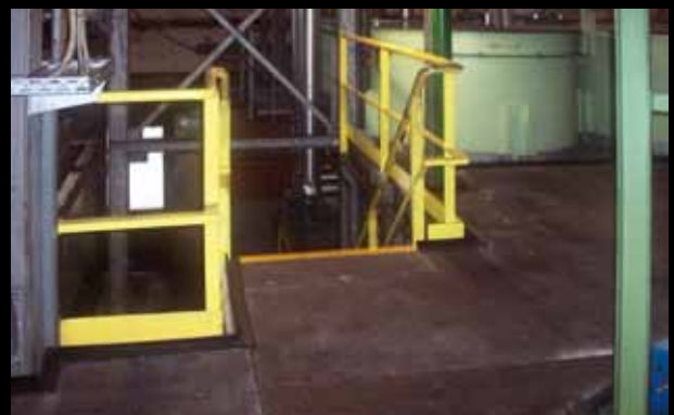
► Xtra Grip Platte, massgenau gesägt und geschraubt auf einem Plattform
